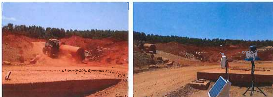
Photo 2 : intervention 1 / juillet 2015 / temps sec propice aux envols de poussières
