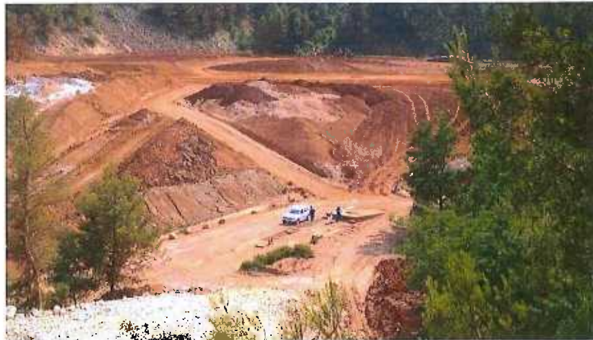
photo 1 / dépôt de bauxaline / mise en place des préleveurs sur la zone de roulage
